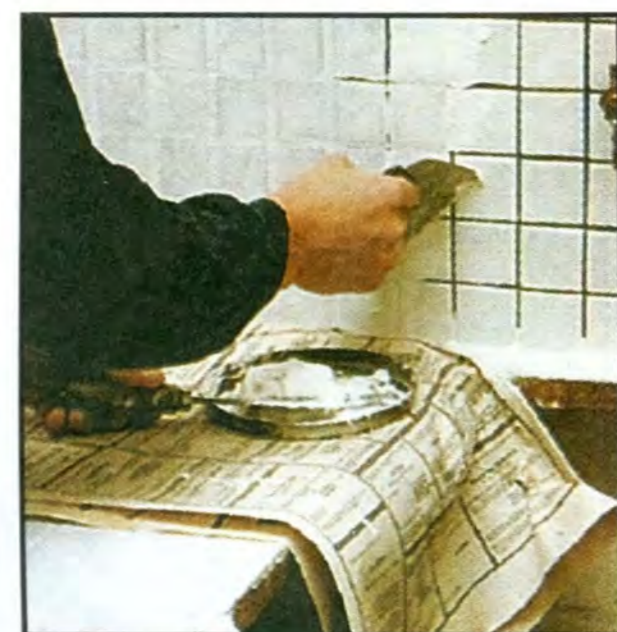
Швы заполняют с помощью широкого гибкого шпателя.
