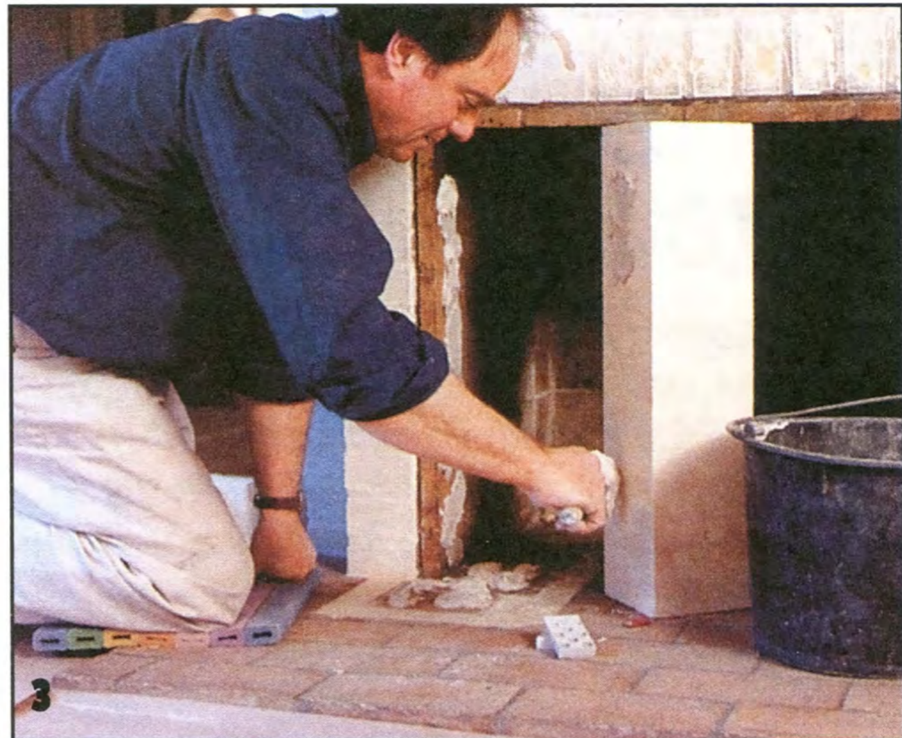
3 Специальный термостойкий клей наносят кельмой на газобетонные детали портала и на участки пола и стены, к которым их приклеивают.
