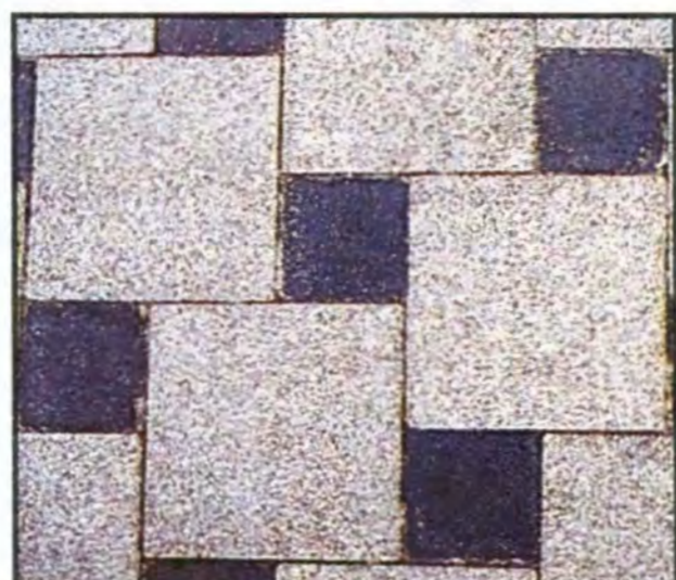
Бетонные плиты размерами 50x50 см с обнаженным заполнителем в сочетании с темными мозаичными камнями.
