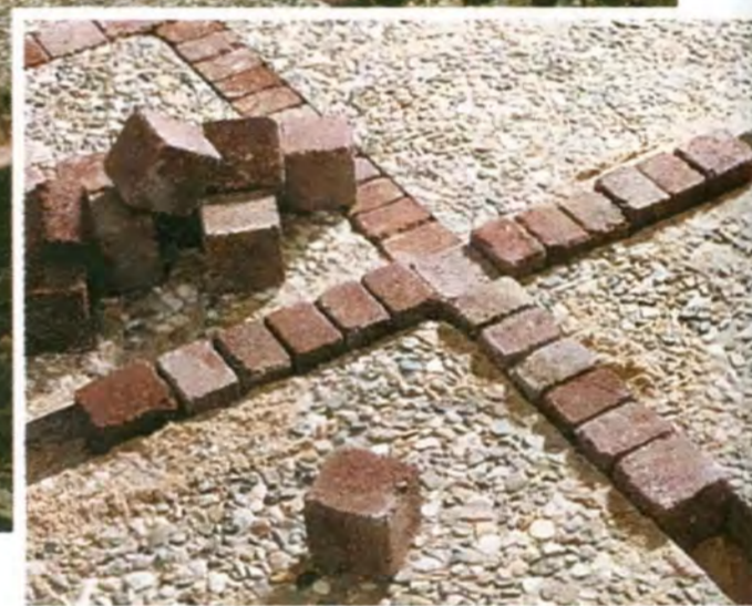
Очищенные от грязи и вновь уложенные старые плиты разделены «строчками» из цветных камней.
