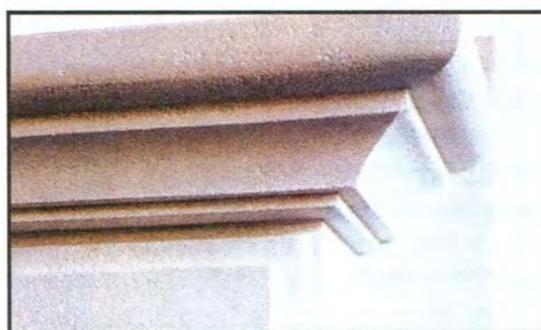
Финишная окраска (и тоже — термостойкой краской) скрывает даже мелкие щели между деталями портала, что придает ему вид монолитного сооружения.
