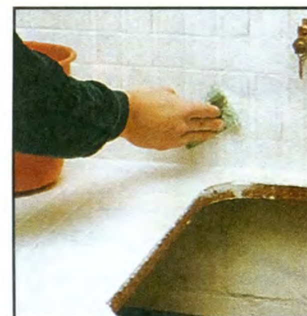
Излишки состава для затирки швов удаляют губкой, обильно смоченной водой.
