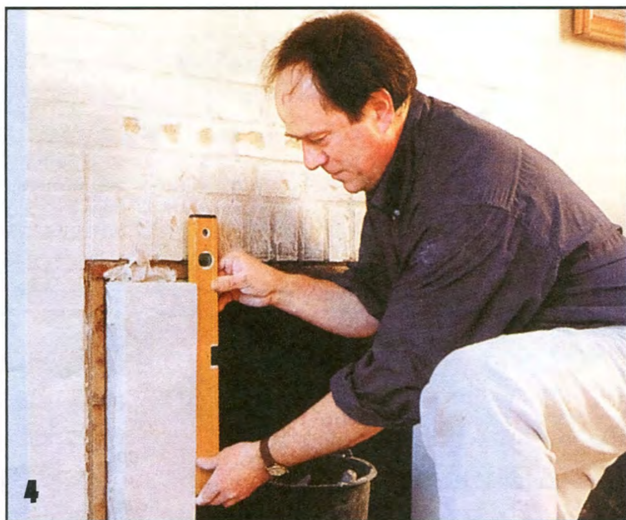
4 Правильность положения деталей обеспечивает точная предварительная разметка и контроль их наклонов по уровню.
