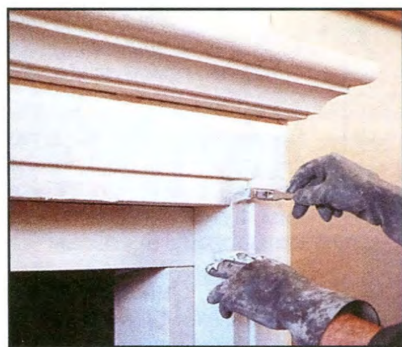
Швы между деталями камина заполняют термостойким составом, а затем, пока раствор не затвердел, разглаживают его кистью.
