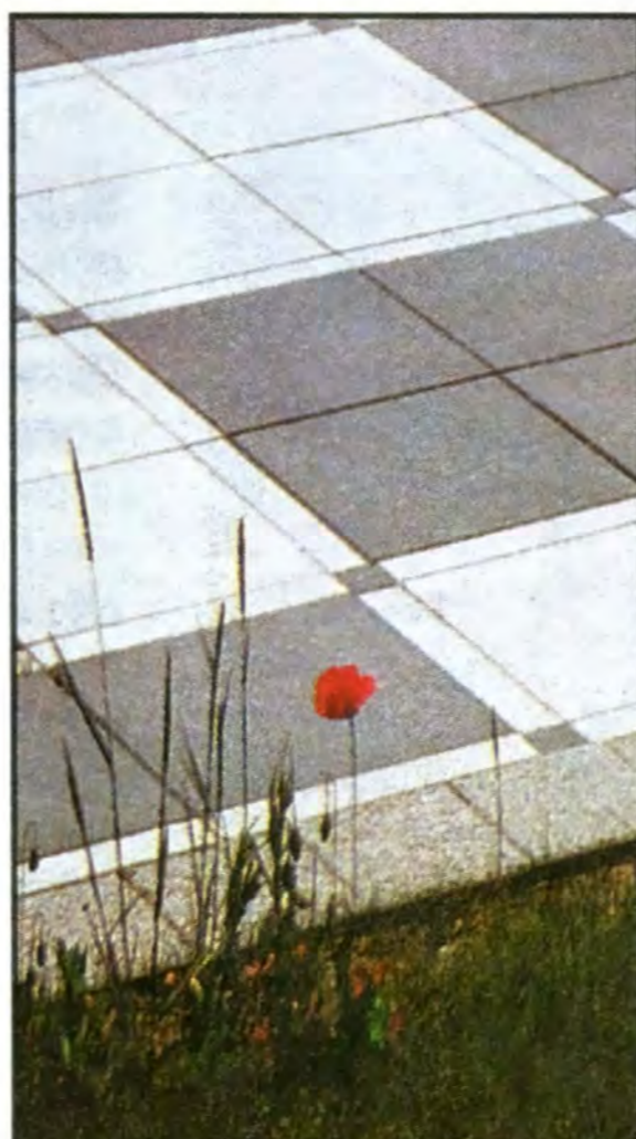
Малоформатные квадраты и узкие полосы чудесно оживляют пол террасы. Каждое из «полей шахматной доски» выложено из четырех светлых и темных крупноформатных плит.
