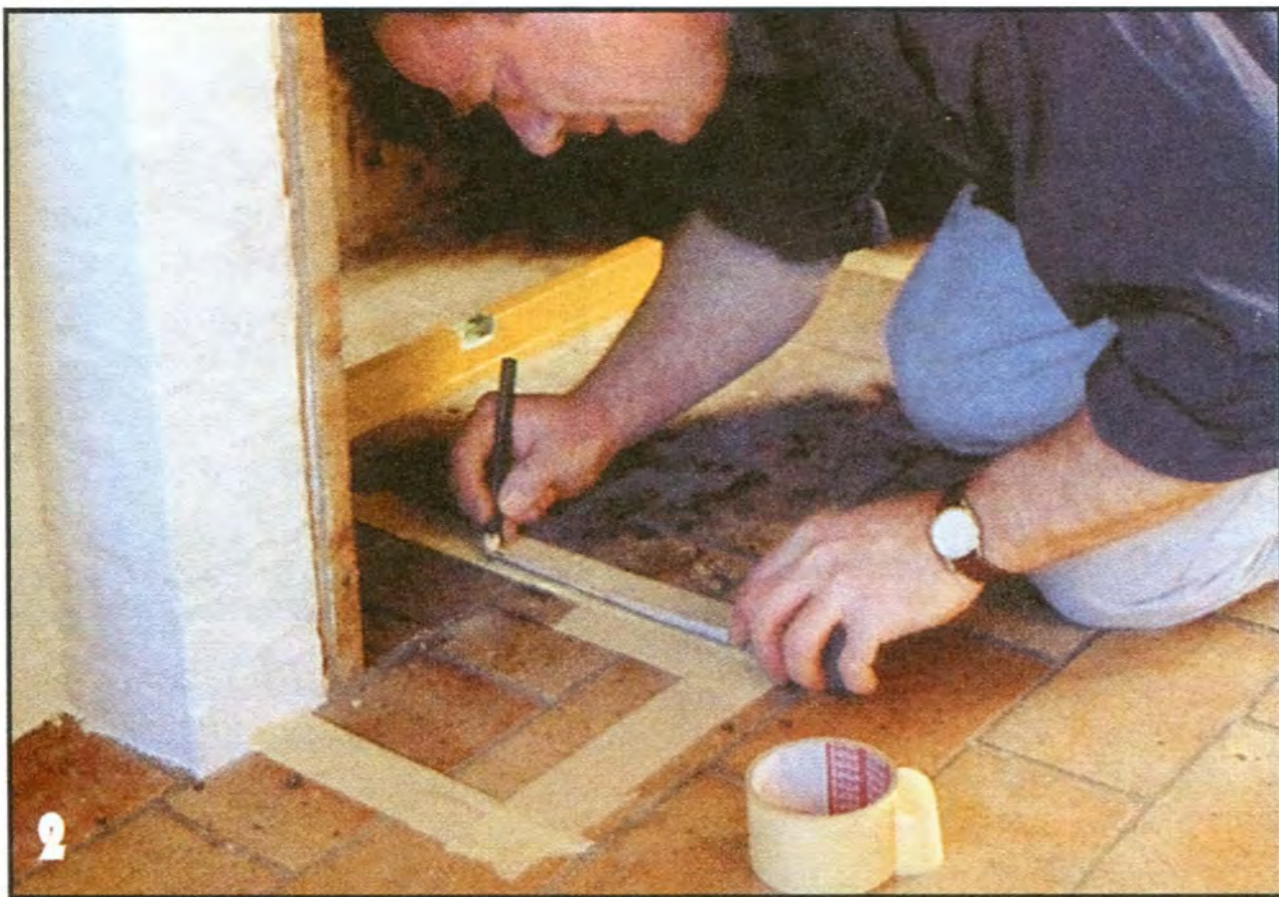
2 Наклеивают на пол обычную малярную ленту и размечают на ней положение деталей портала.
