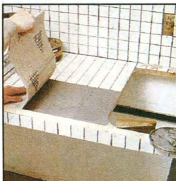
Раскроенный по размеру блок мозаичной плитки кладут на клей.
