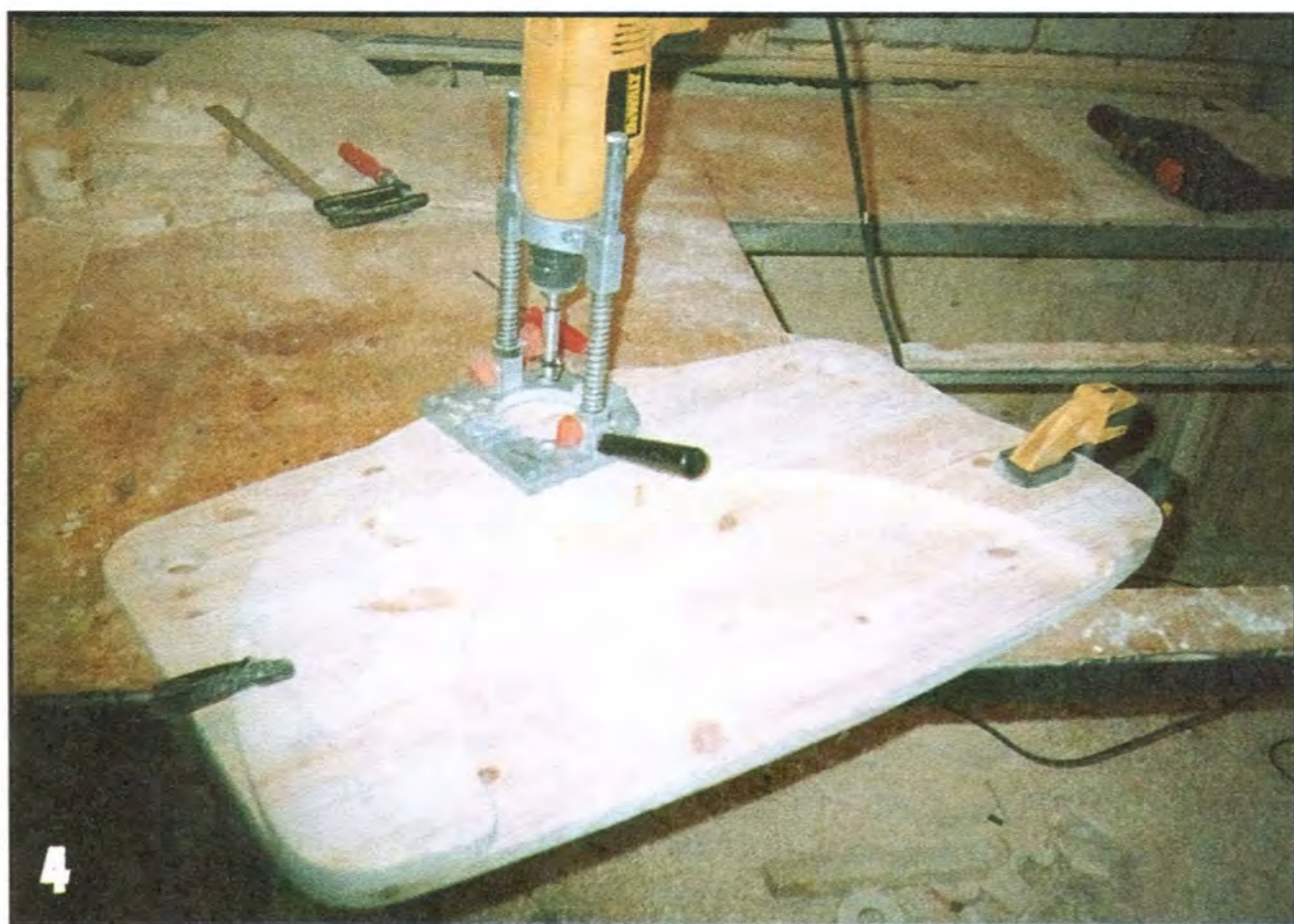
Отверстие \varnothing 22 мм под центральную стойку я сверлил, установив дрель в стойку, обеспечивающую перпендикулярность сверла пласти детали.
