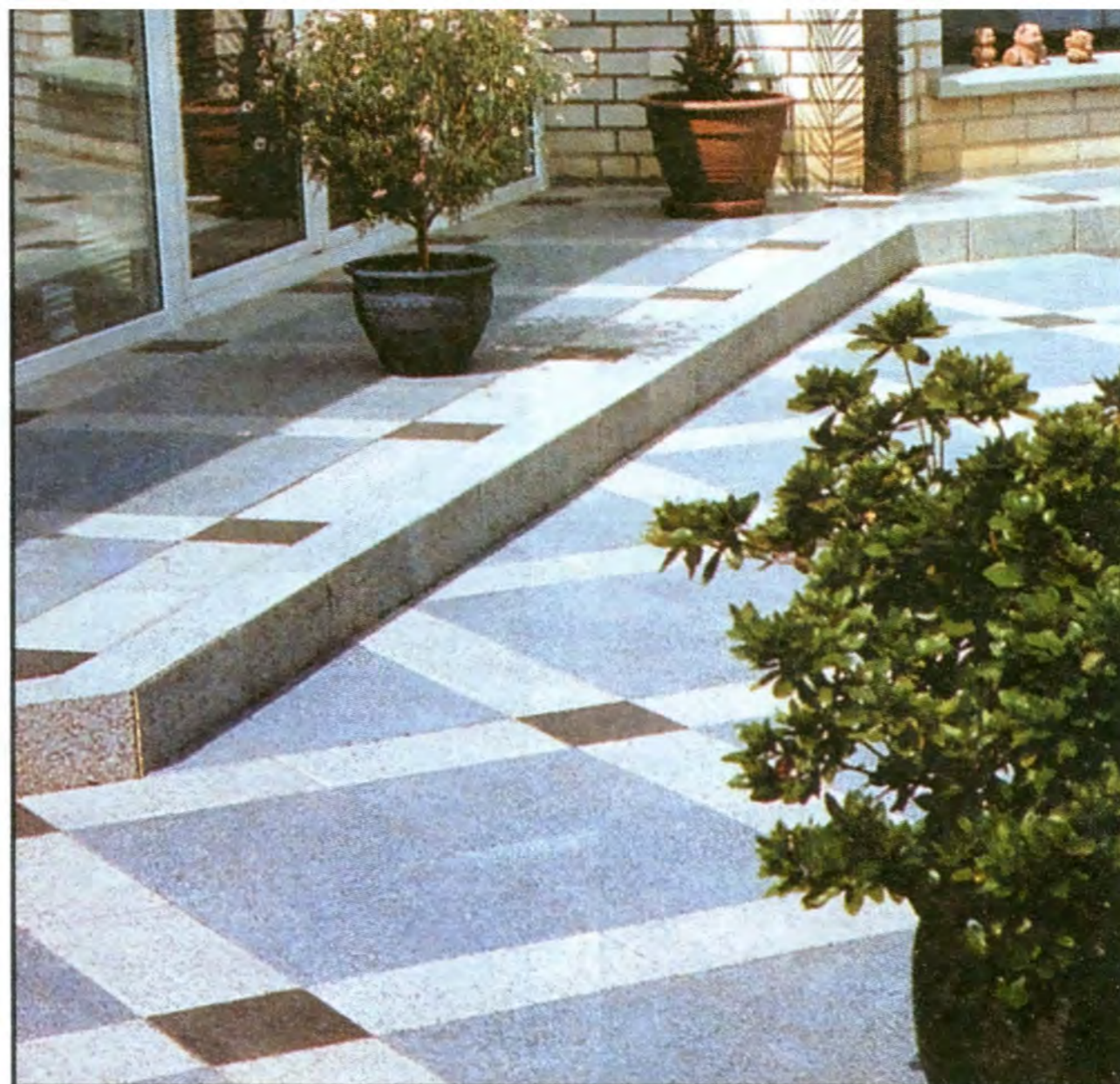
Это покрытие устроено из старых плит размерами 50x50 см и новых плит двух различных форматов и цветов.
